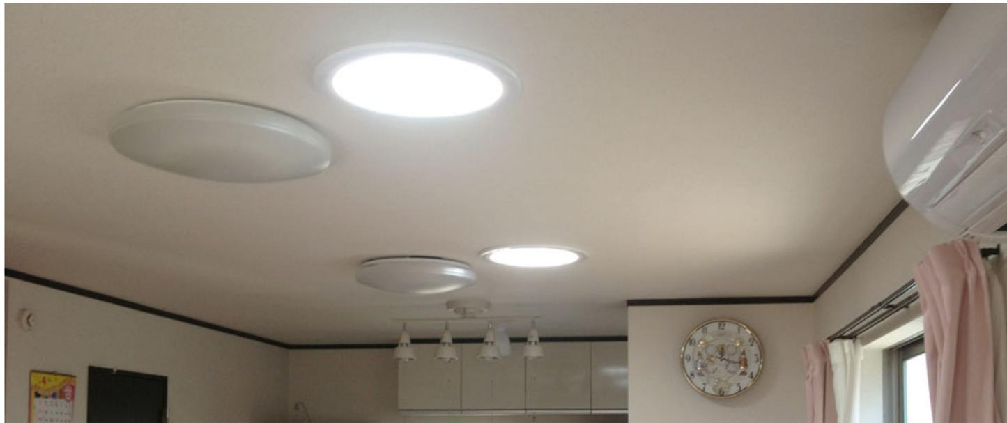
スカイライトチューブは窓から十分な明るさが得られない室内（暗い部屋）を太陽の明るさでいっぱいにする設備です。気持ちの良い明るさが日の出から日の入りまで、晴れの日はもちろん曇りや雨の日でもその時々での外の明るさを届けてくれます。しかも通常の単板ガラスと違って紫外線と熱を持ち込まないシステムになっていますので、家具などの日焼けや夏の熱さも心配ありません。高反射率の反射チューブで天窗で明るくするのが不可能な場所にだってチューブを配管することが出来ればどこへでも。新築はもちろん、既築の建物にも導入できますので、部屋が暗くてお困りの方、採光にご不満のあったお客様宅へ採光リフォームをお届けしています。
